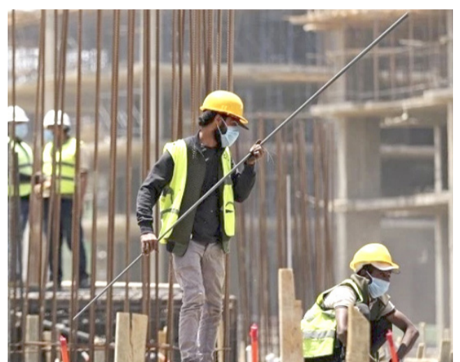
مشروع: عمال اجانب في مشروع
