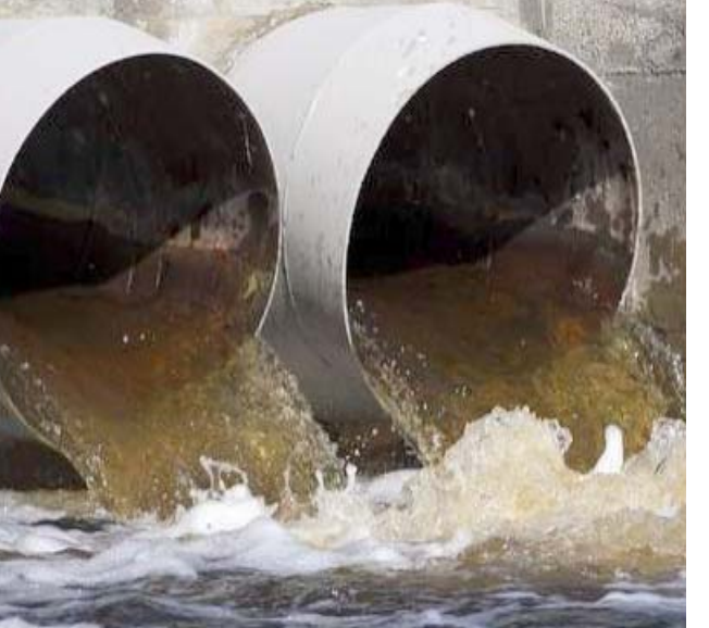
مياه الصرف الصحي تملأ المبالز
