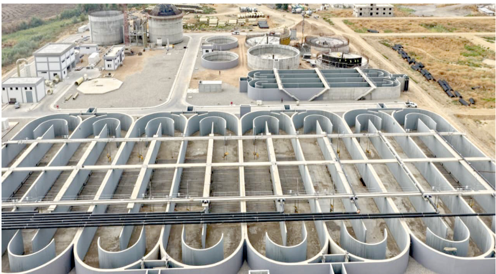
مشروع - استمر العمل في مشروع الصرف الصحي بأيمن الموصل
