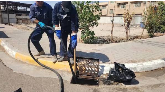
تنظيف، عامالن ينظفان فتحة لتصريف مياه الأمطار
